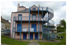
Maison du canal Fégréac
