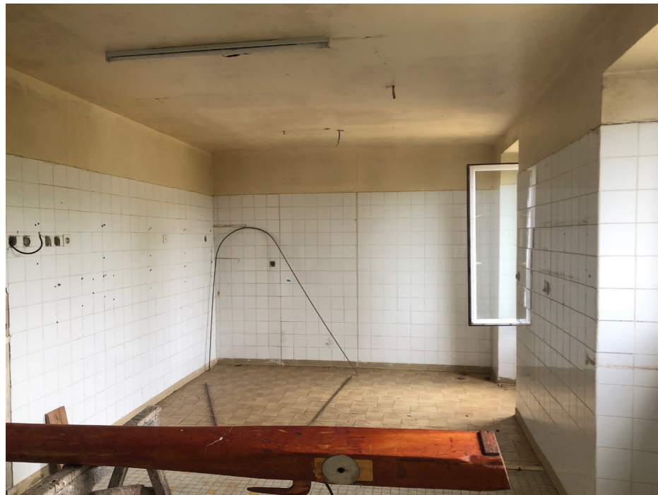
À l'intérieur, le bâtiment possède une multitude de pièces. La distribution n'est pas facilement compréhensible. On sent que l'organisation de l'espace s'est faite au fur et à mesure des usages sans chercher de cohérence d'ensemble.
