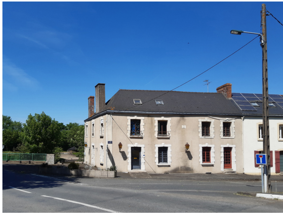
Le bâtiment du restaurant forme la proue du hameau de Port Beslé. Depuis les différentes rues ou point de vue, il marque la jonction avec l'espace public et le paysage.
