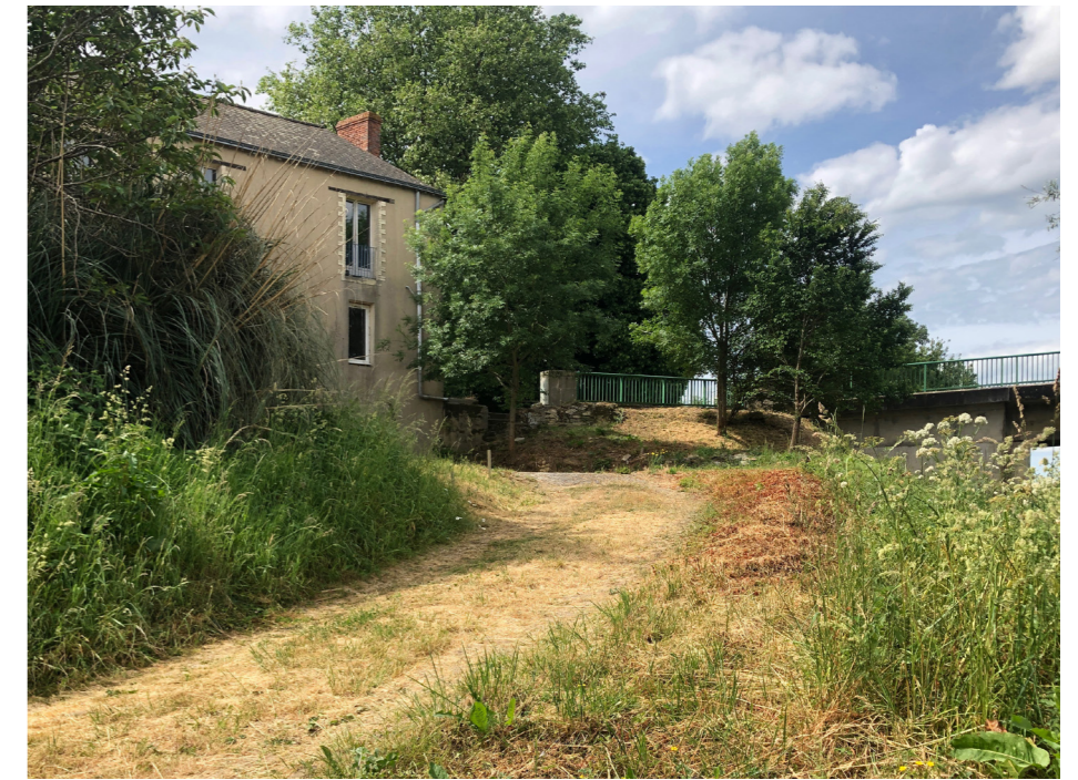
Côté Vilaine, on découvre le bâtiment depuis les cheminements piétons. L'escalier permettant de remonter vers le pont se devine assez mal et est peu confortable.
