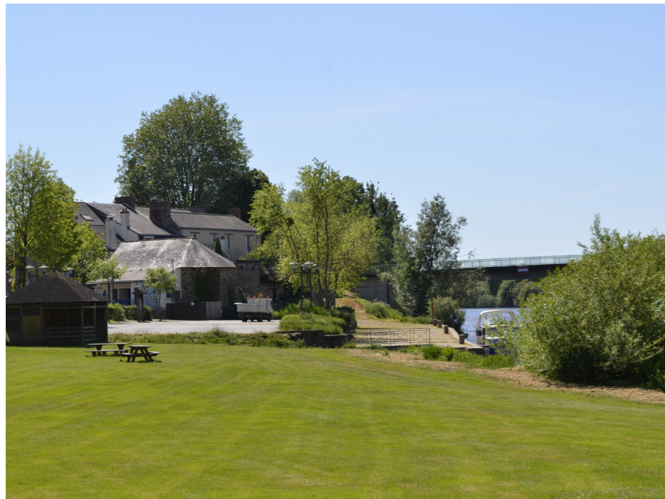
Le bâtiment émerge du paysage et reste visible depuis le Port.
